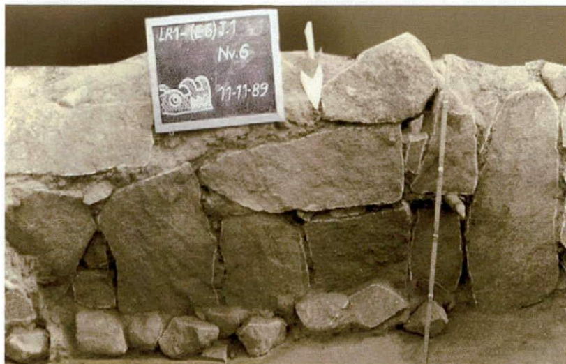
Figura 13.14: Paramento externo del muro perimetral (E6)
