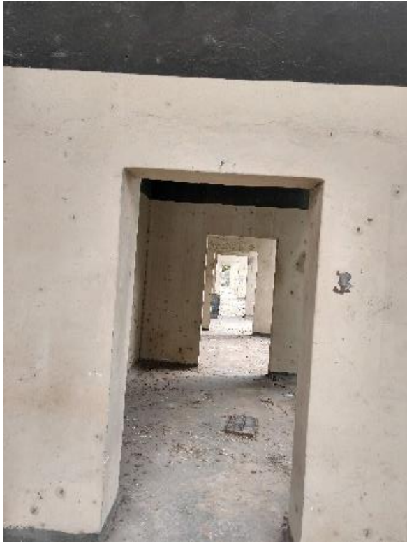
Imagen 4.9. Pórticos comunicantes en el subsuelo del Pabellón de los felinos. Fuente: fotografía propia (2022).
