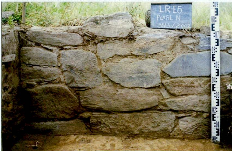
Figura 10.14: Sector del muro norte de E5.
