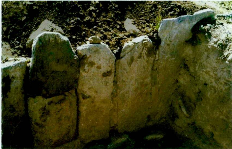
Figura 10.13: Sector del muro este (perimetral) de E5.
