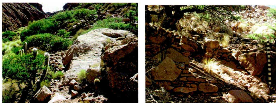
Figura IV 11. Quebrada de Pojcho con detalle de los muros de contención.
