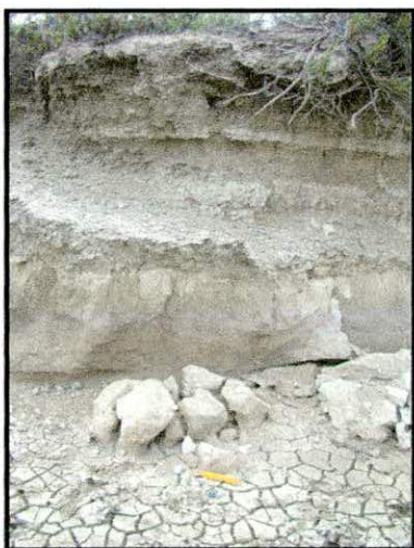
Figura 10.48. Derrumbe de barranca.
